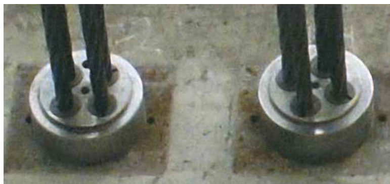
Установка обоймы анкера
